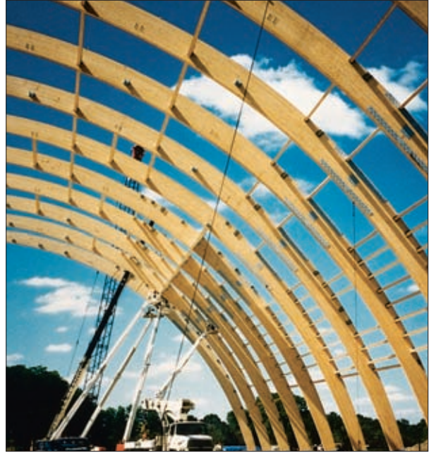
Arcos de glulam soportan el techo de las instalaciones de práctica de los Chicago Bears en Lake Forest, Illinois.
