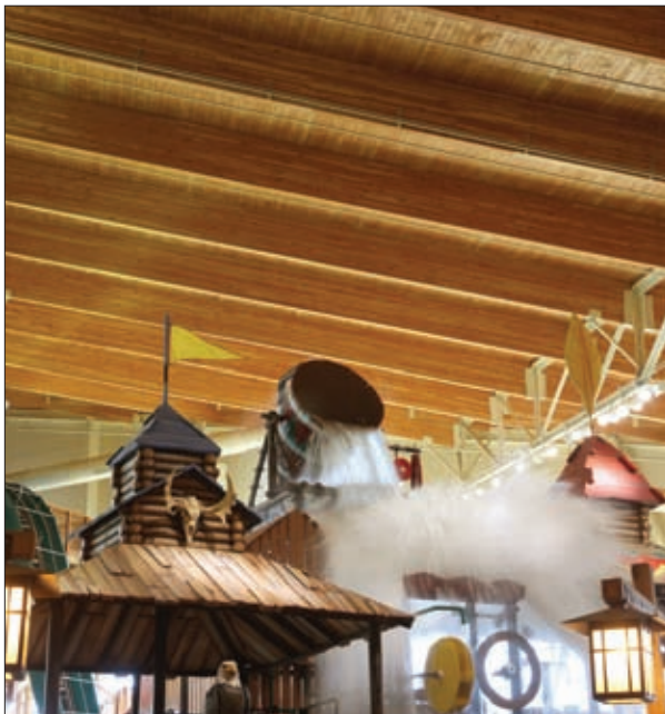
El Great Wolf Lodge en Grand Mound, Washington incorpora vigas de glulam de 65 pies sobre el parque acuático bajo techo.
