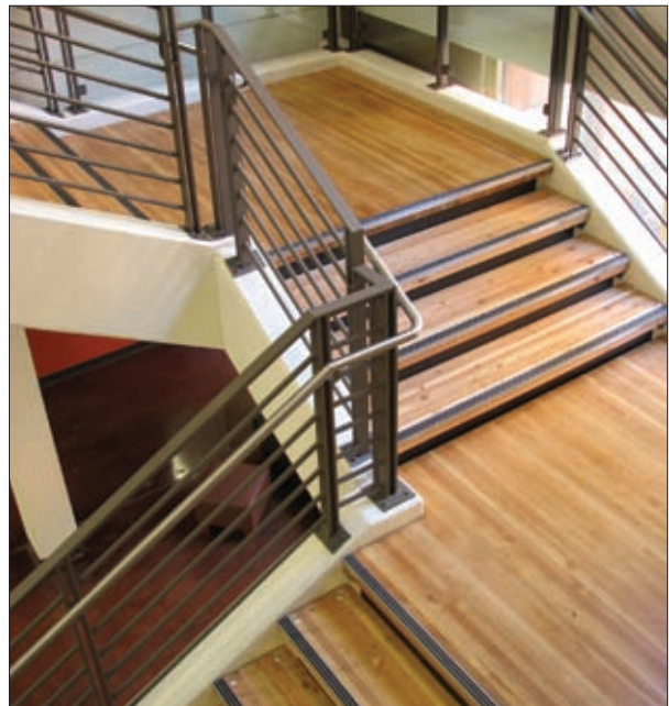
Elementos duraderos de glulam forman una escalera resistente.
