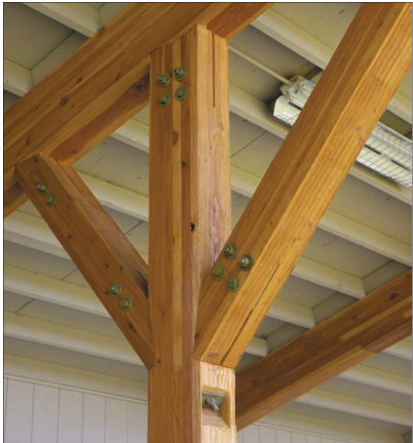
Estos elementos de glulam utilizan muescas y conectores estructurales ocultos, para crear un diseño limpio y elegante.
