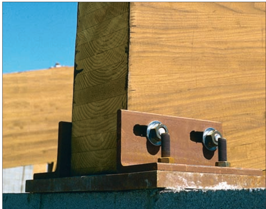
Ranuras para pernos permiten el movimiento horizontal de una viga con inclinación y curva.
