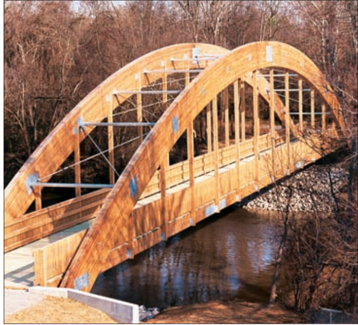
El puente sobre el río Tar en Rocky Mount, Carolina del Norte incorpora arcos de madera laminada encolada.
