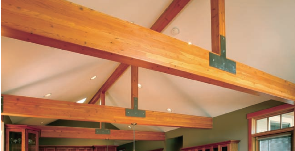
Los arcos a la vista de glulam en la viga cumbre y los apoyos intermedios de este condominio residencial suministran una apariencia impactante además de integridad estructural.
