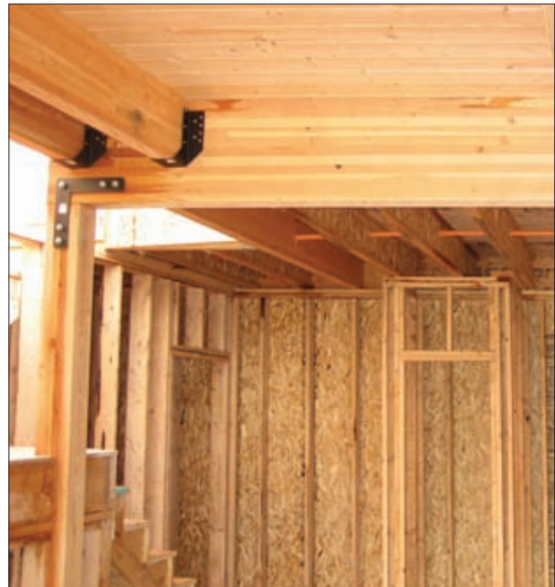
Columnas y vigas cabezal de glulam suministran el apoyo primario para la construcción de este condominio.
