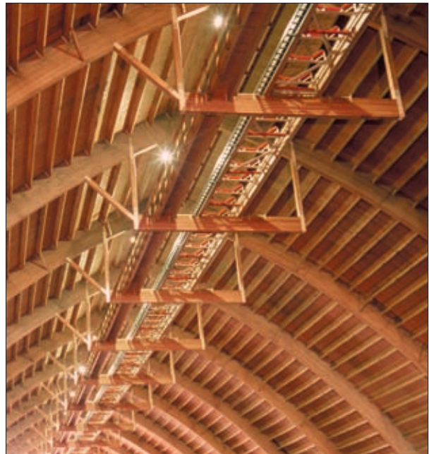
Este almacén de fertilizante de 236.000 pies cuadrados en Portland, Oregon incorpora arcos de glulam.
