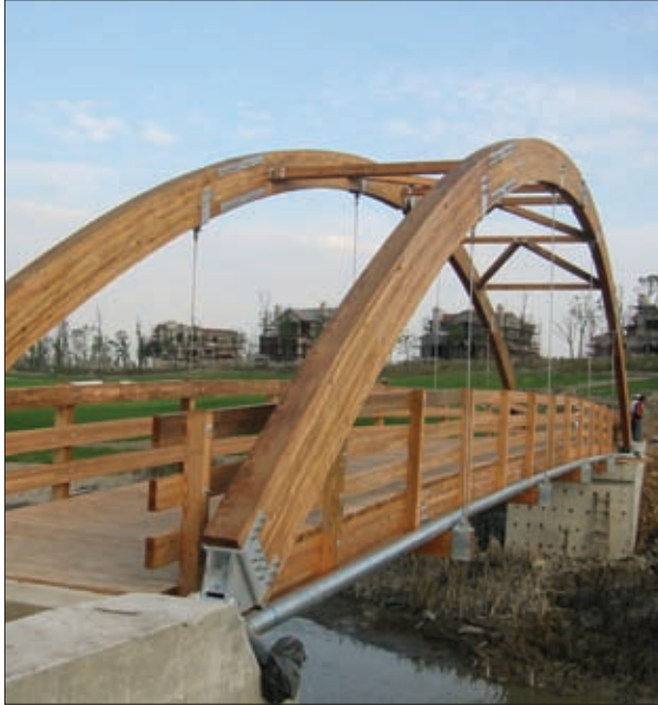
Este puente de glulam conecta el campo de golf Sheshan con una lujosa comunidad residencial, y suministra tanto elegancia como funcionalidad. El proyecto despertó un nuevo interés en el uso de glulam en puentes de campos de golf en China.
