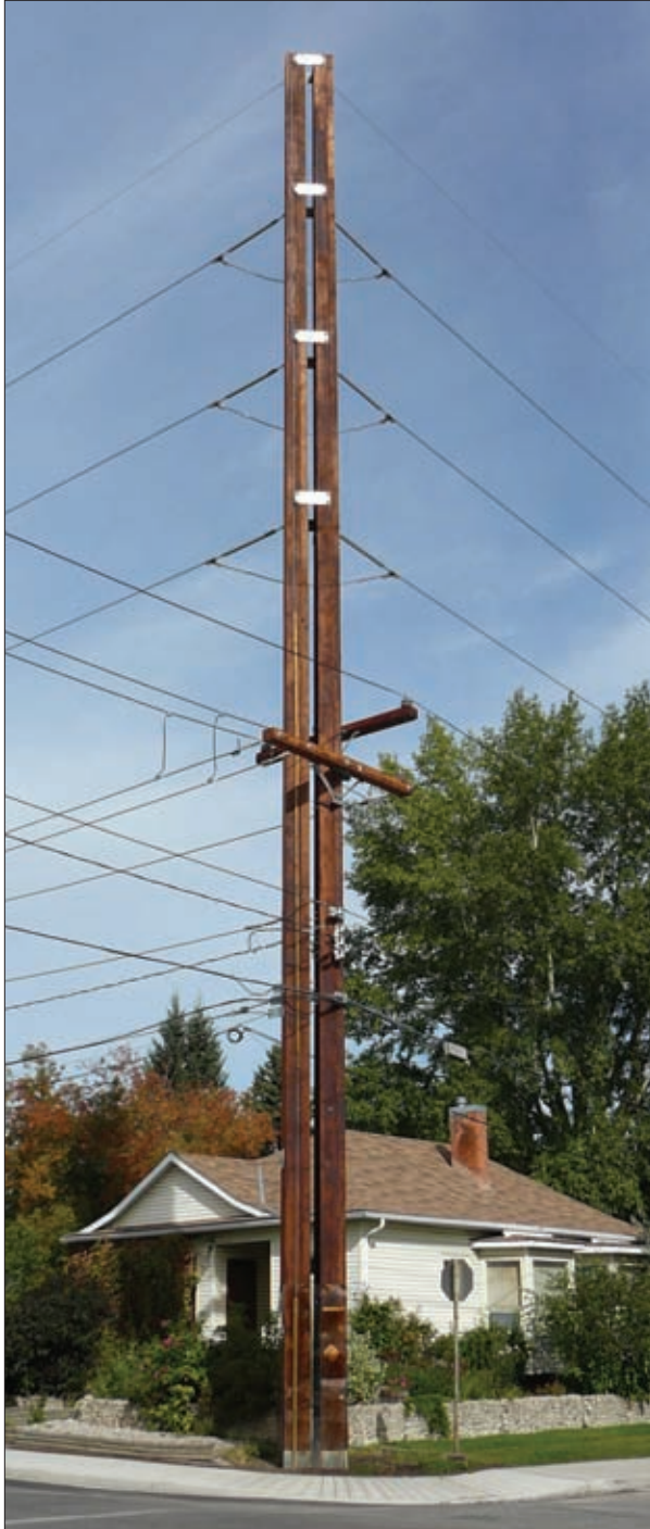
Dos postes de 107 pies están aperrados en este diseño único de poste de servicios. Fotografía cortesía de Western Archrib.
